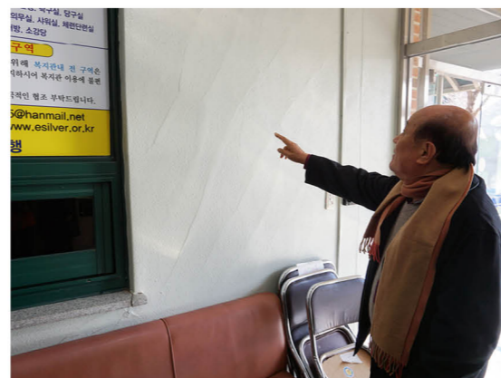
페인트로 눈가림한 별관 1층 내벽을 가르키는 이용객
