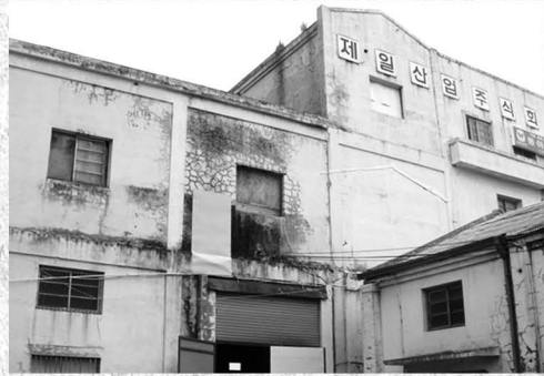
지금은 사라진 호남제분 건물, '제일산업', '동아원' 등이 보인다.(2007년 촬영)
