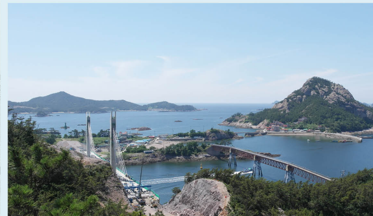
산이 절개되고 있는 고군산대교 공사 현장(8월 촬영)
