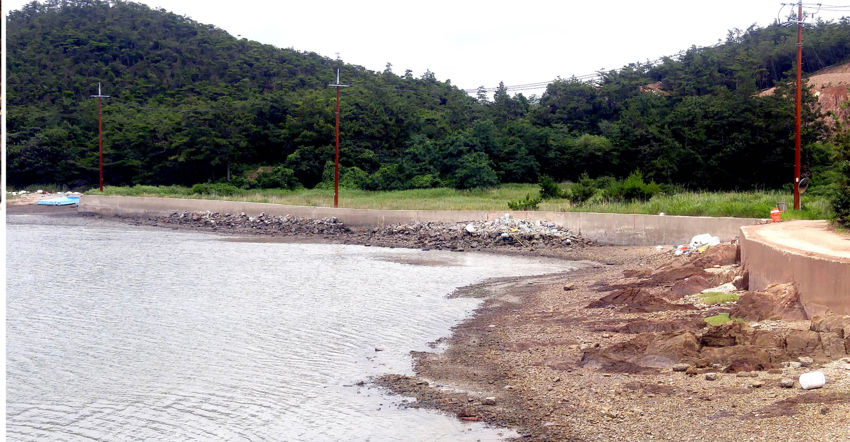
멀리서 본 버럭샘 전경. 1930년대 초에 길이 70미터 제방을 1년여 간의 노동으로 바닷물 유입을 막아 60년도 말까지 일부 마을 주민들이 거주했던 곳이다. 초기 제방을 막았던 돌은 형태만 남아있고 지금은 시멘트로 막아져 있어 견고하다.
